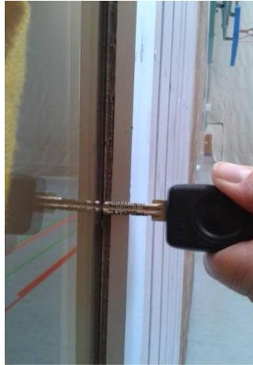
Sichtfenster nicht bündig in Prallwand integriert. Elastisch eingebaut?
