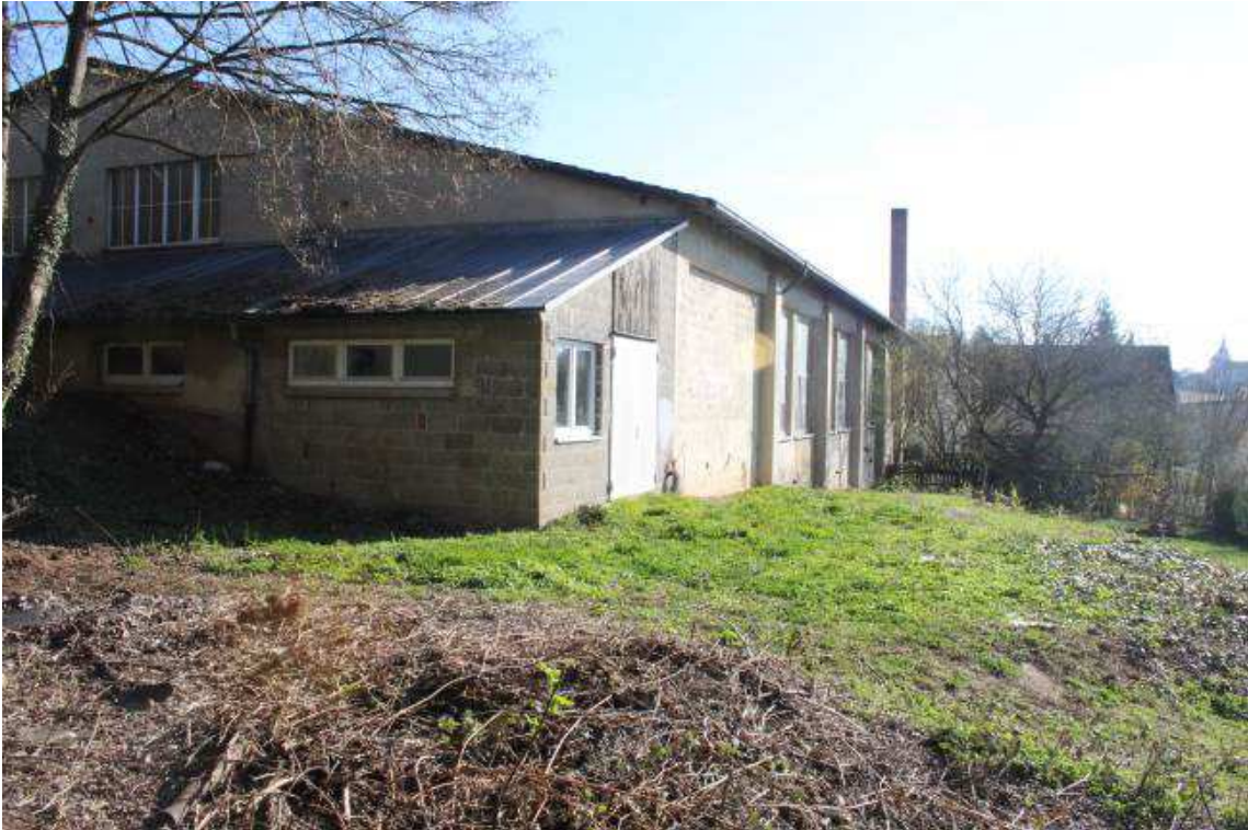
Abb. 2: Gewerbegebäude von Südwesten
