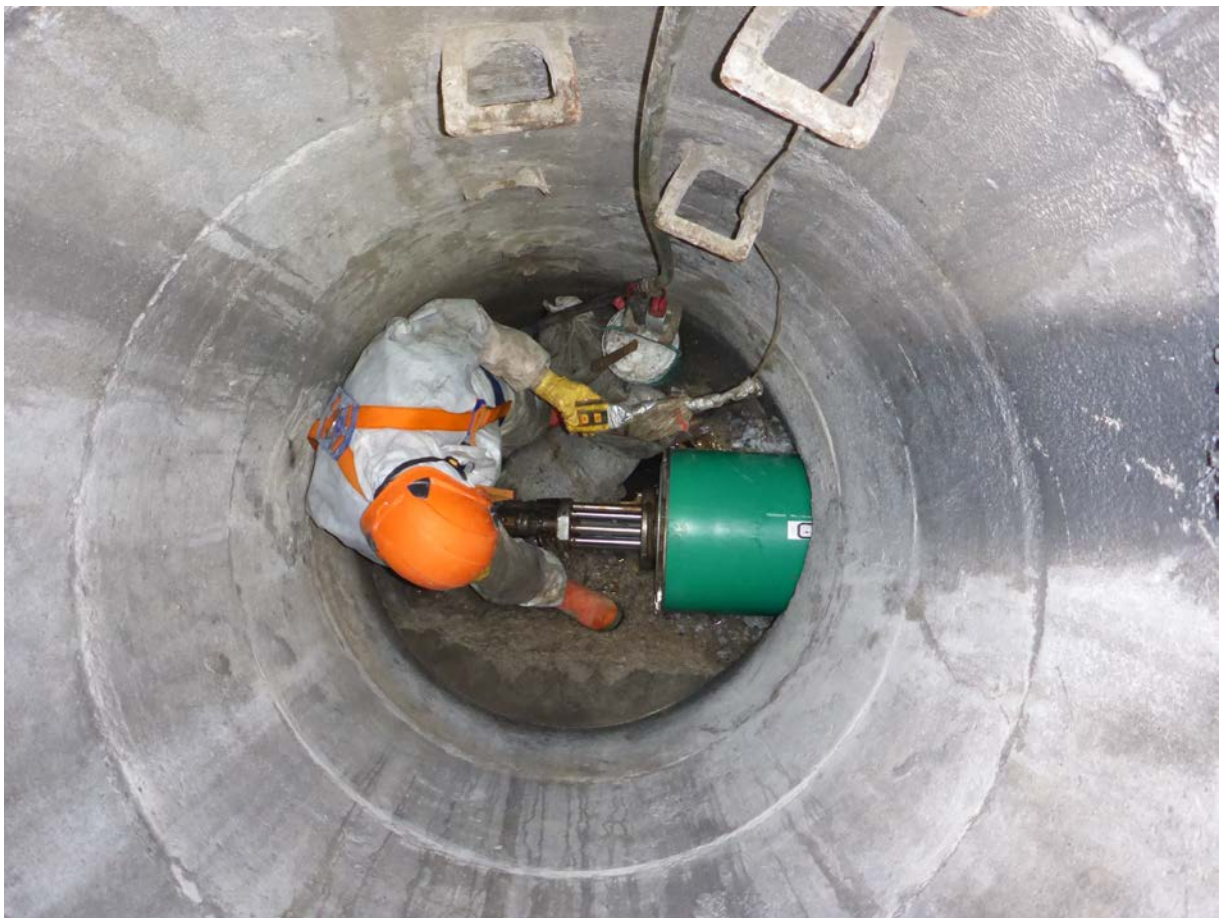
Kanalrenovierung Sulzbacher Straße
